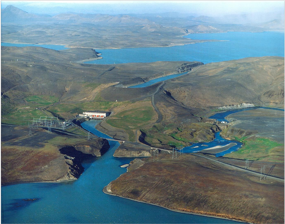
MYND 2. Sigöldustöð og tengivirki. Krókslón efst á myndinni og Hrauneyjalón neðst. Farvegur Tungnaár til hægri. (Mynd: Emil Þór Sigurðsson).
